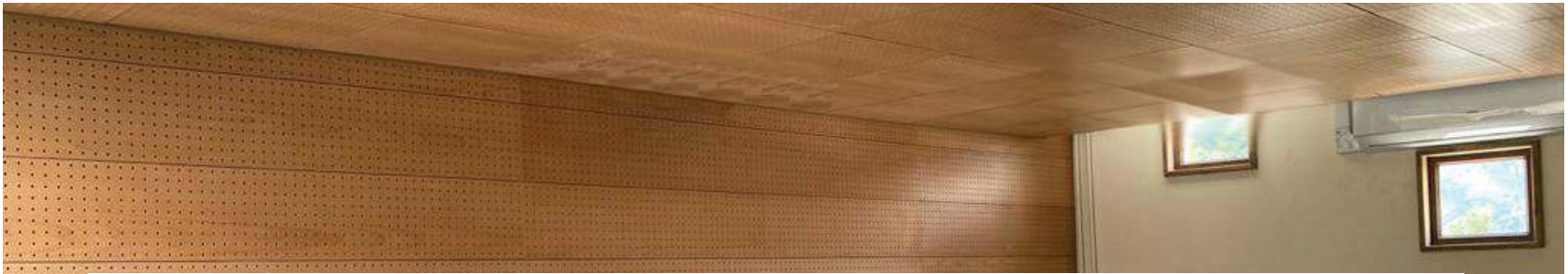
TEC-ACUSTIC 16 CARA OCULTA Perforaciones de 10 mm Paso 1: 16 mm; Paso 2: 16 mm (+ Viledón)
